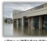
＜冠水により被害を受けた店舗＞
